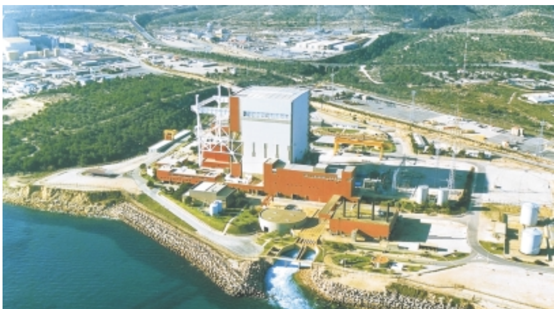
Desmantelamiento Vandellós I (Nivel 2). Vista general de la central antes del inicio de los trabajos de desmantelamiento.
