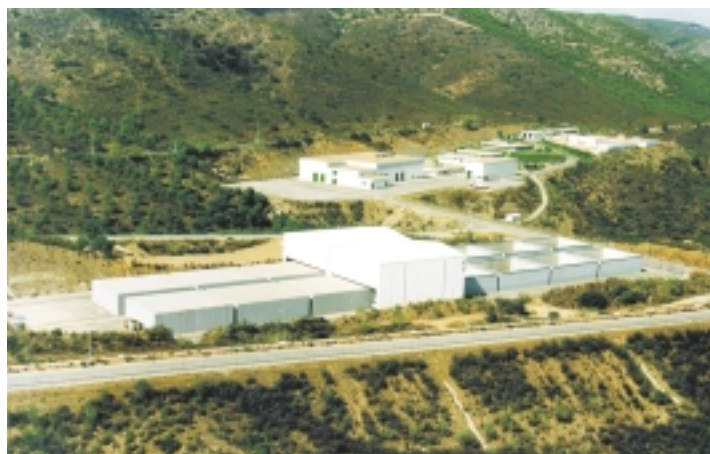
Vista general de la plataforma norte donde actualmente se están almacenando los residuos.
