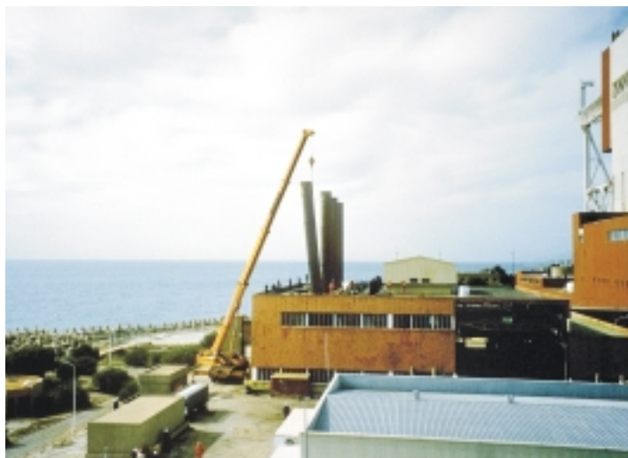
Desmantelamiento Vandellós I (Nivel 2). Desmantelamiento de instalaciones auxiliares.
