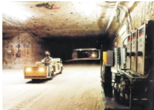
Vista interior de las galerías principales del WIPP.
