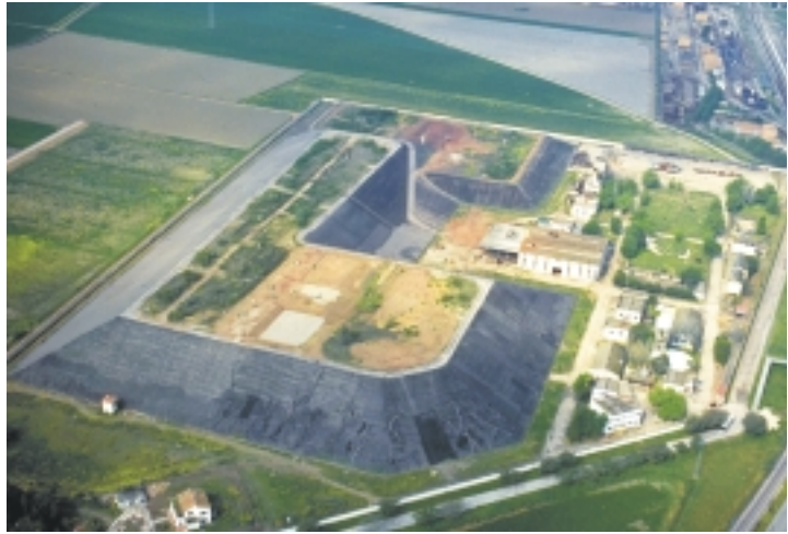
Fábrica de Uranio de Andújar. Situación de las antiguas instalaciones antes de su desmantelamiento.
