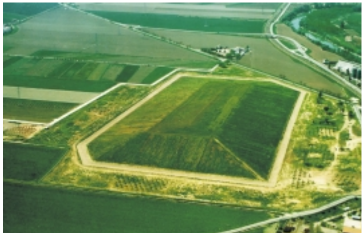
Fábrica de Uranio de Andújar. Estado final del emplazamiento después de las labores de desmantelamiento realizadas por ENRESA.
